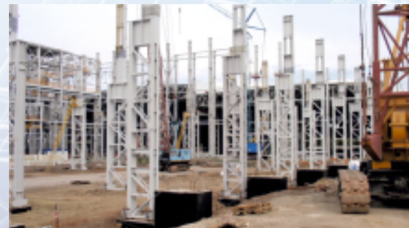
Металлоконструкции для завода, г. Каменск Уральск Объем м/к – 1956 т
