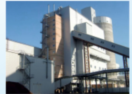
Цементный завод (комплекс зданий), г. Новотроицк Объем м/к – 5 262 т
