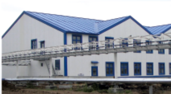
Металлоконструкции объектов зданий для объектов трубопровода «Восточная Сибирь-Тихий океан», Станция Лена Объем м/к – 1900 т
