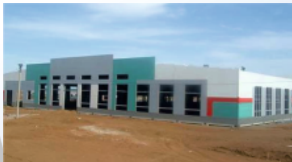
Корпус завода по производству стекловаты (комплекс зданий), г. Елабуга Объем м/к – 3000 т
