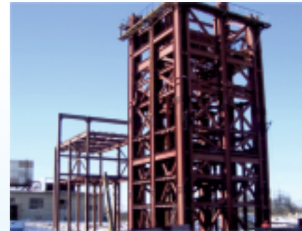
Надшахтный комплекс шахты «Новая» (Копер и надшахтное здание), г. Гай Объем м/к – 2 588 т
